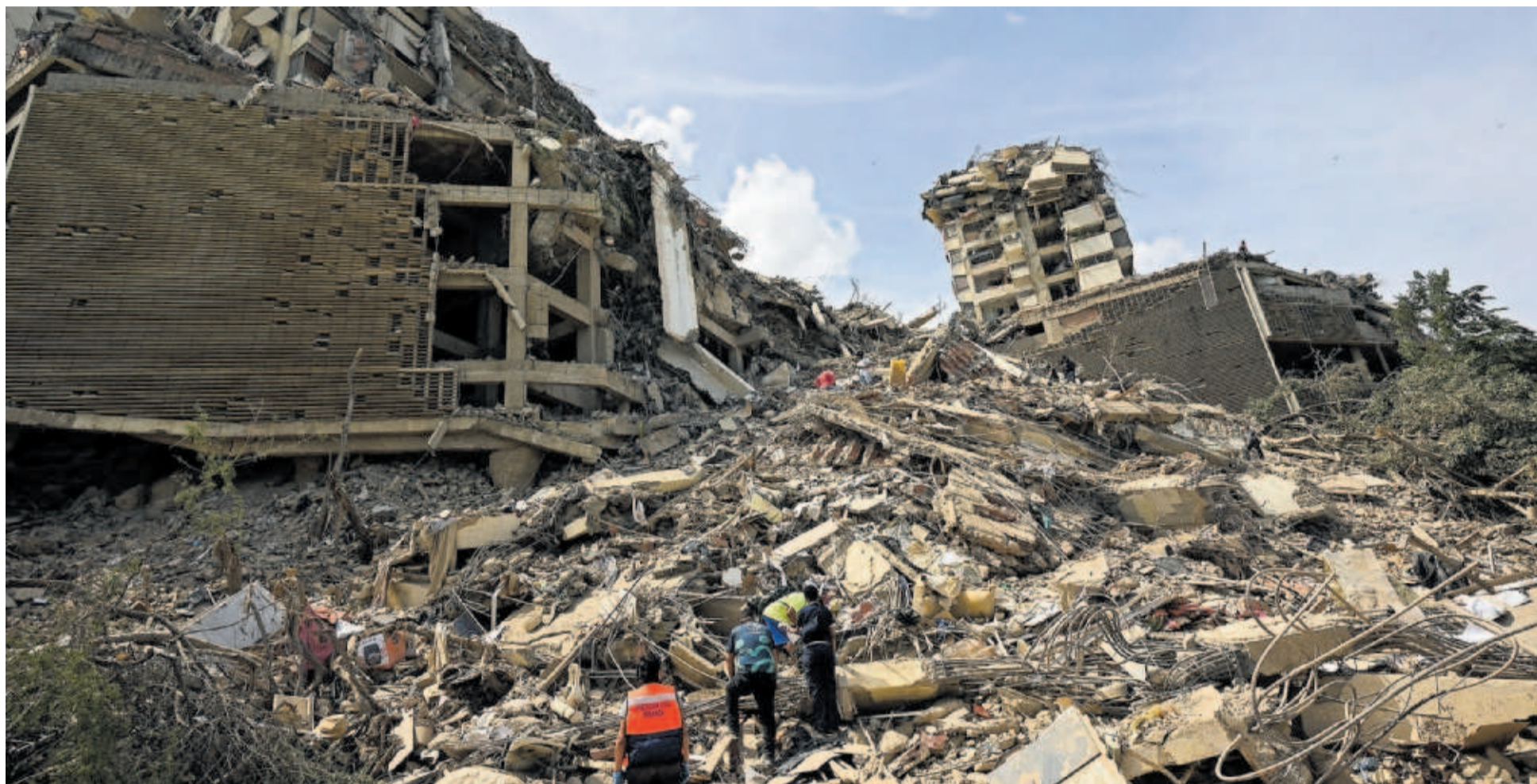
Búsqueda de desaparecidos ayer entre los escombros de edificios derrumbados en La Guaira, cerca de Caracas. MAXWELL BRICEÑO (REUTERS)
