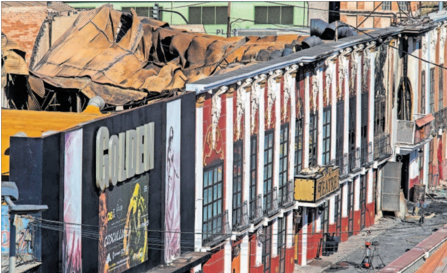
Las discotecas Golden, Teatre y La Fonda, en Murcia, con el techo de las dos últimas derrumbado por el incendio del domingo. / MARCIAL GUILLÉN (EFE)
