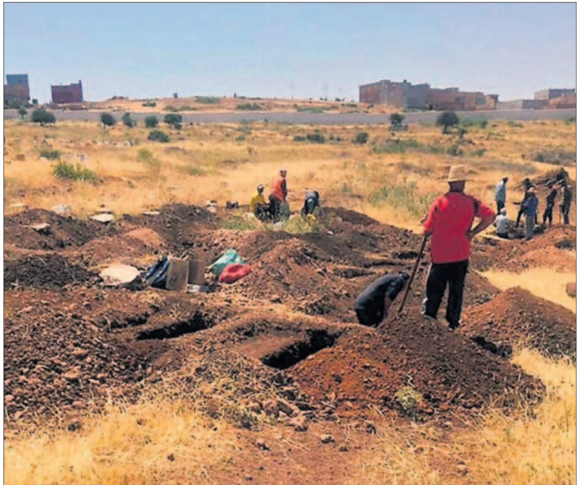
Varios operarios cavaban ayer una veintena de fosas en el cementerio de Nador, en Marruecos.
