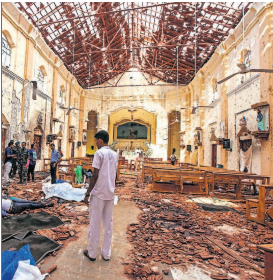
Interior de una iglesia de la localidad de Negombo, tras la explosión de una bomba. / C. KARUNARATHNE. (AP)
