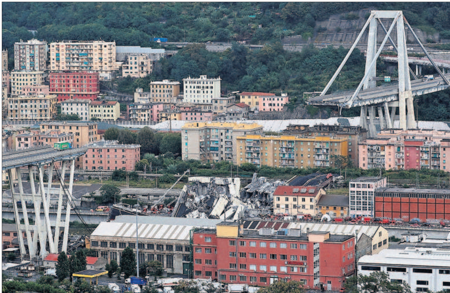
Tramo del puente que se desplomó ayer en Génova. / STEFANO RELLANDINI (REUTERS)
