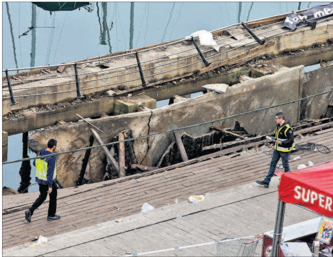
Estado en el que quedó la estructura que se hundió este lunes en el muelle de Vigo. / LALO R. VILLAR (AP)
