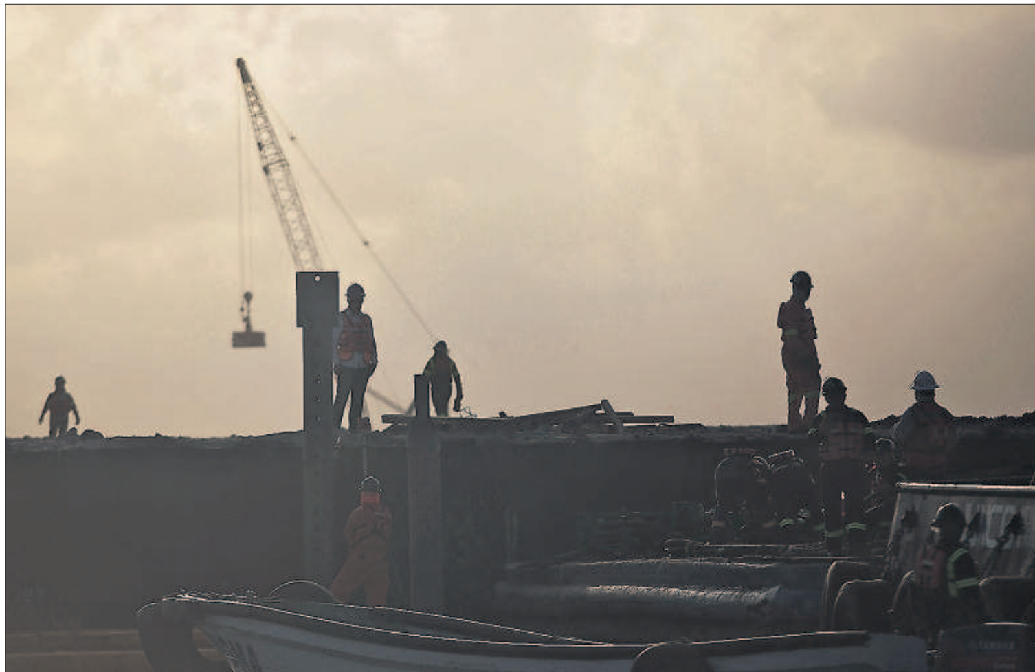
Obras en uno de los 32 muelles que están siendo construidos en Veracruz. / MÓNICA GONZÁLEZ
