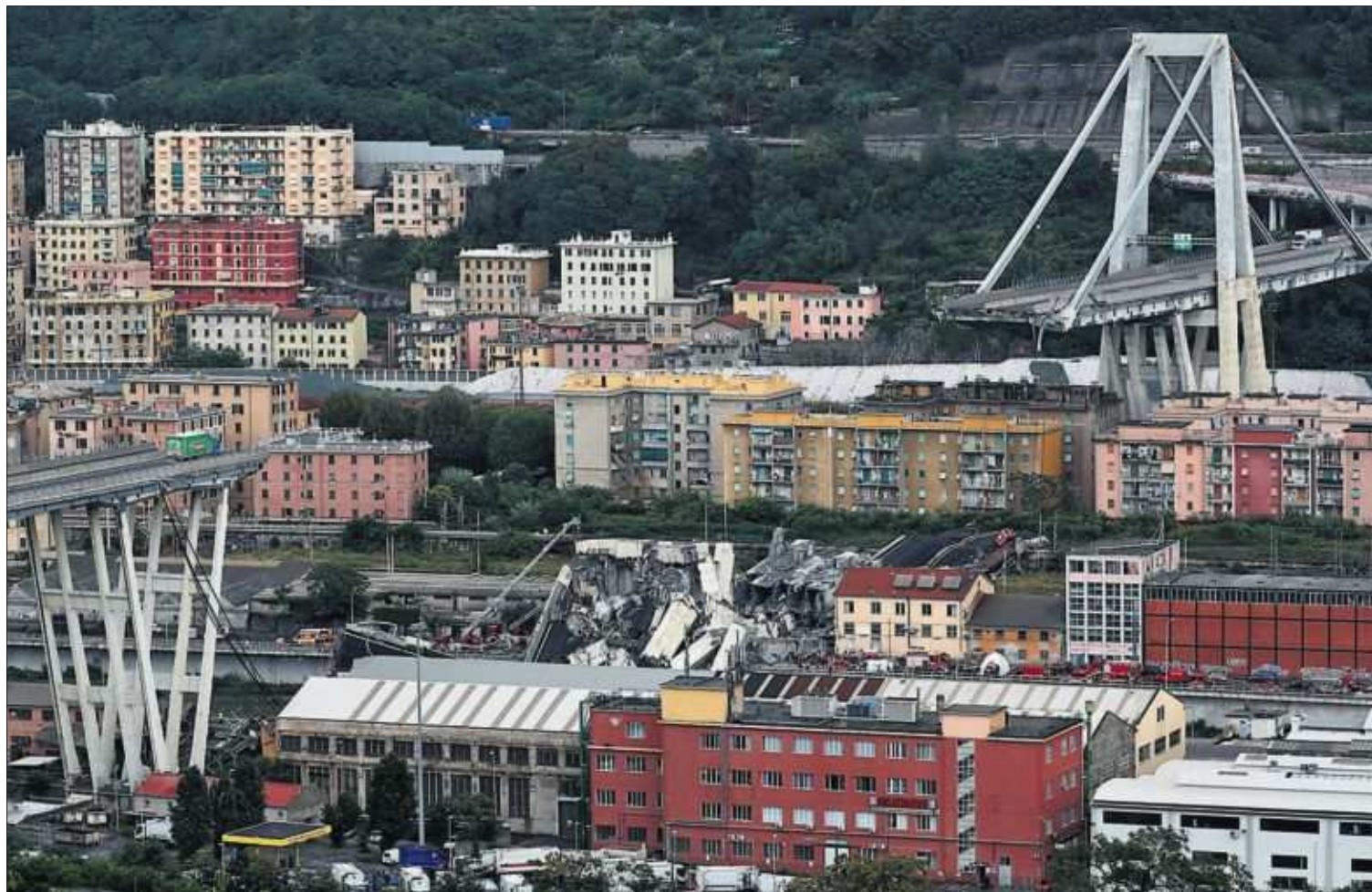
Tramo del puente que se desplomó ayer en Génova. / STEFANO RELLANDINI (REUTERS)
