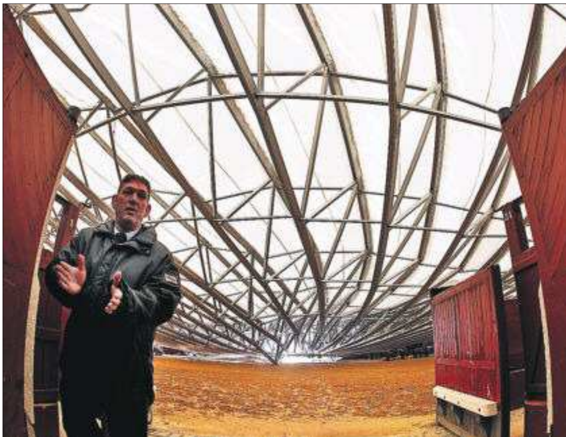
LA CUBIERTA DE LAS VENTAS SE DESPLOMA TRES DÍAS ANTES DEL ESTRENO. La estructura que cubriría la plaza de toros de Madrid duró un día. A las 4.45 de ayer, el techo móvil de 160 toneladas se derrumbó sin causar heridos. Warner Music, que pagó la obra a cambio de programar fuera de la temporada taurina, suspendió los actos para 2013, que empezaban con una fiesta este jueves. / CRISTÓBAL MANUEL PÁGINA 20
